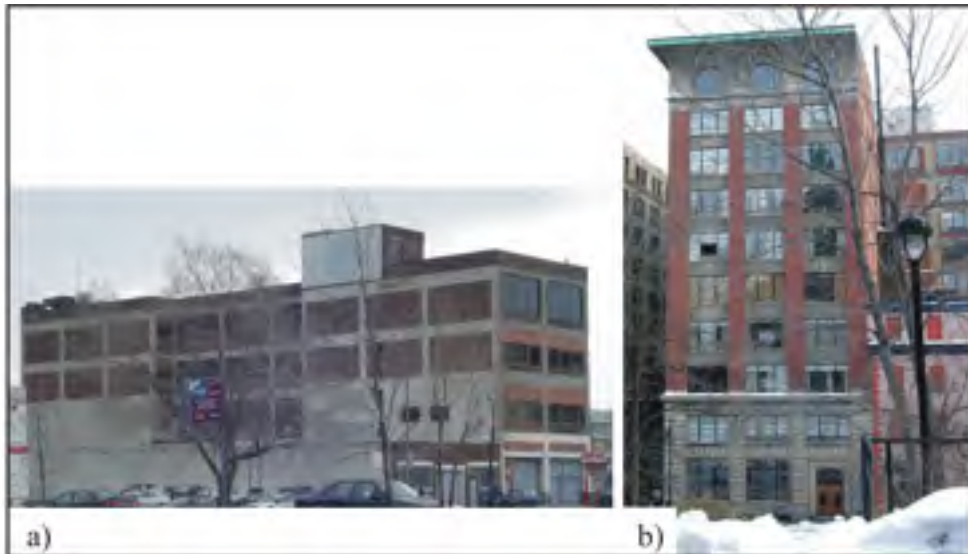
Figure 1.1 Exemples de bâtiments à ossature de béton armé et murs de remplissage de maçonnerie à Montréal b) Tirée de Hamel (2007)
