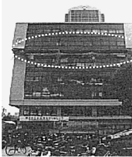
Figure-A XIII-1 Écrasement d'un étage d'hauteur moyenne ( collapse pancake ) Tirée de Shinozuka et al. (1995)
