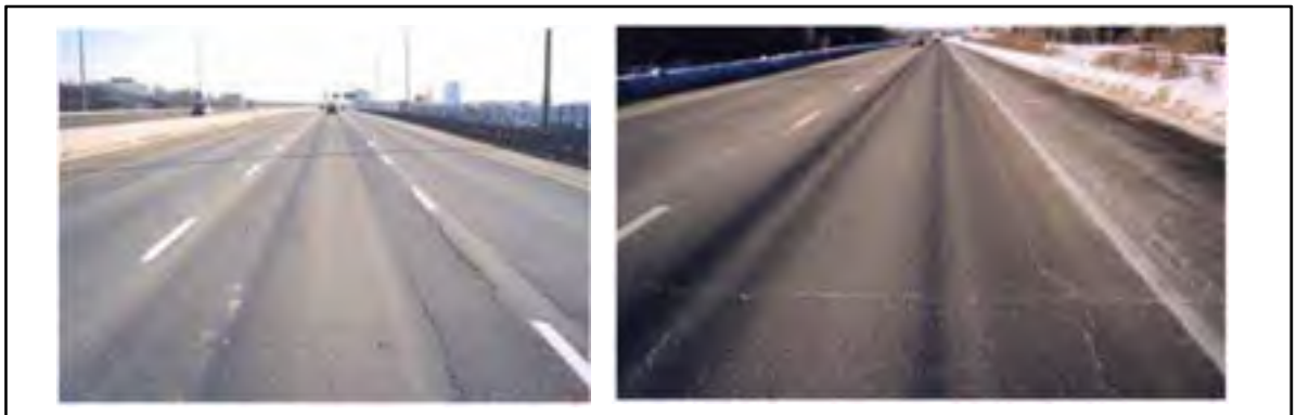
Figure 0.4 Illustration d'ornières observées sur les chaussées – sévérité élevée Source MTQ Info DLC Vol.10 No.1 (2005)
