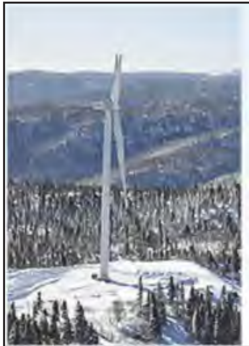
Figure 2.1 Éolienne Repower MM92 du SNEEC Tirée de TechnoCentre éolien (2012)
