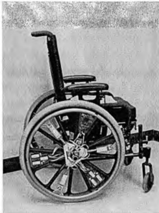
Figure 1.2 La roue instrumentée SMART Wheel montée sur un fauteuil roulant.
