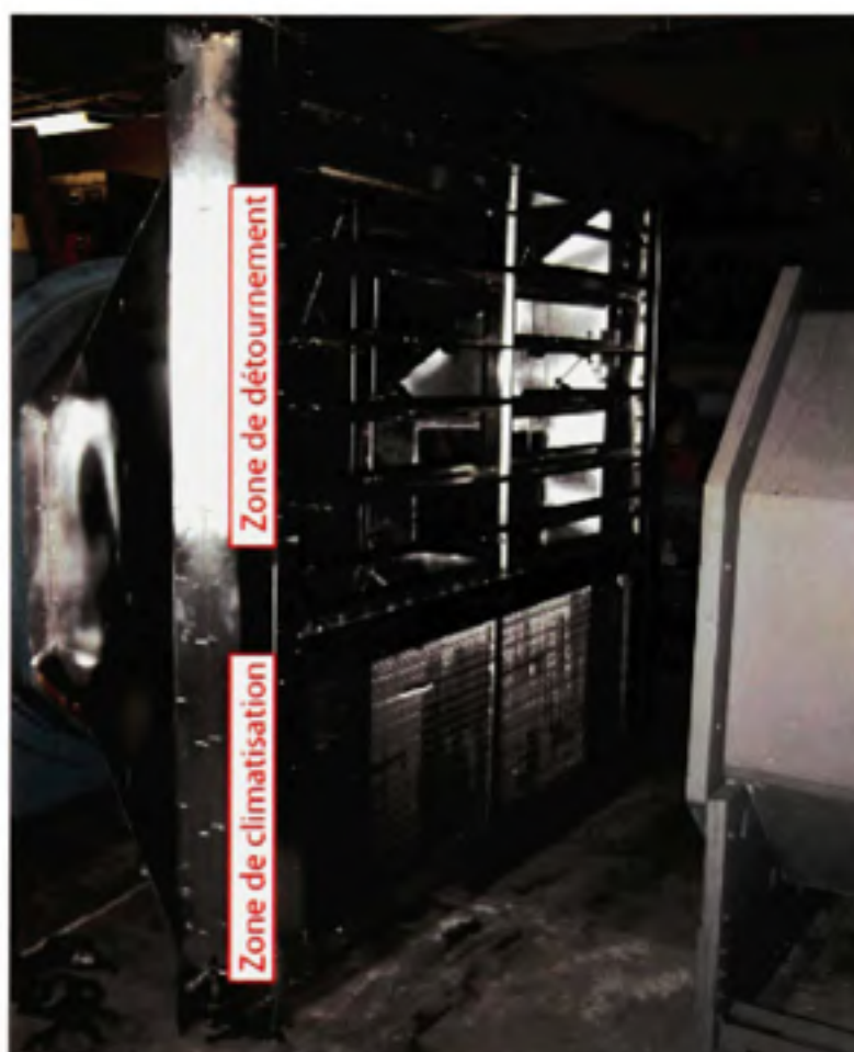
Figure 4.6 Photo illustrant le système de climatisation lors de son installation
