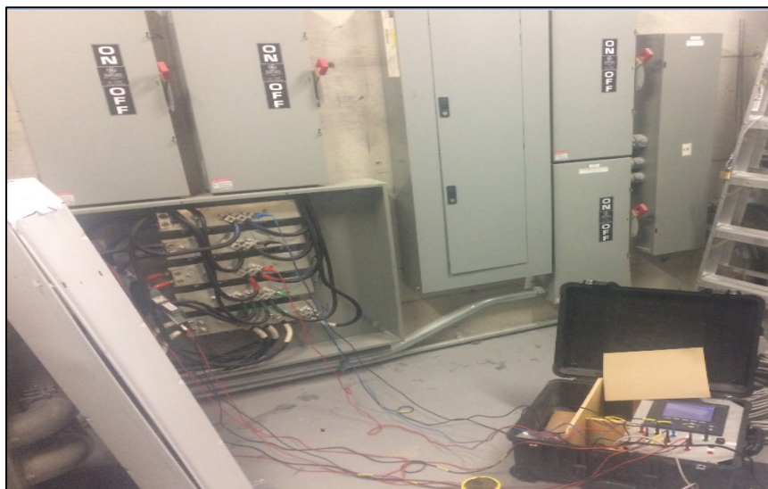
Figure 3.3 Exemple de mesures réalisées au niveau d'un panneau alimenté par l'un des transformateurs
