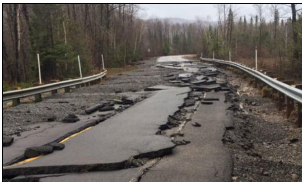
Figure 2.6 Soulèvement de la couche de surface Tirée de Bérubé (2017)
