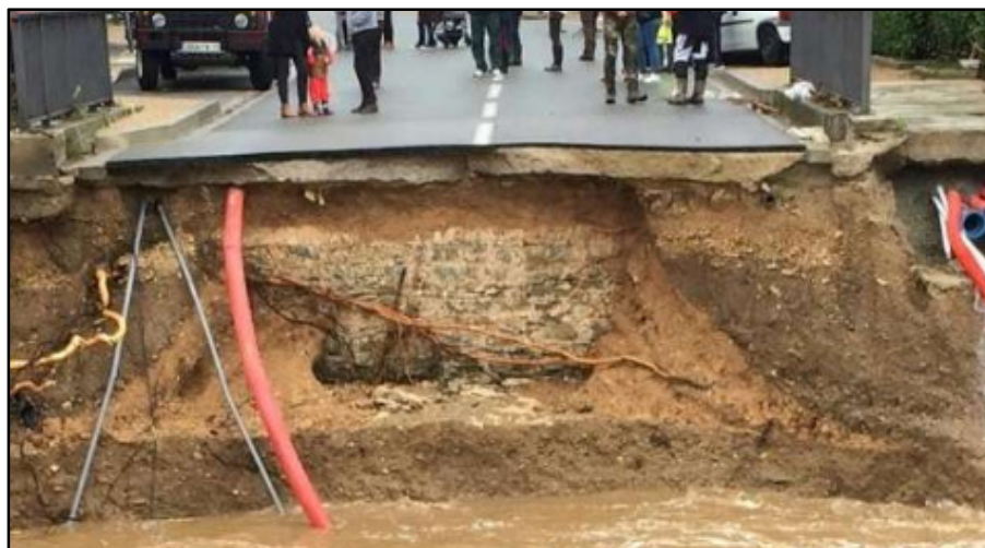
Figure 2.25 Rupture de la chaussée Tirée de Canabis (2018)
