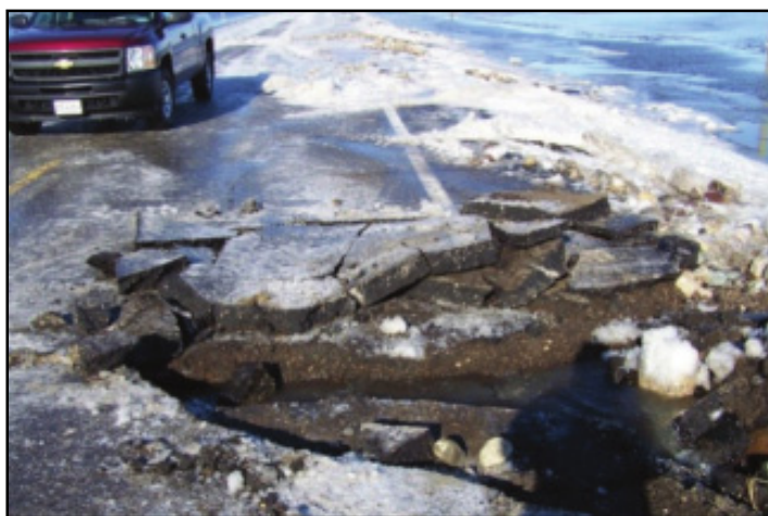
Figure 2.13 Dégâts par érosion Tirée de Briaud & Maddah (2016)
