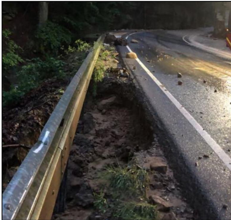
Figure 2.27 Érosion des accotements Tirée de Regenfällen (2018)
