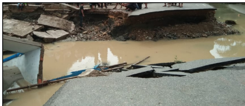
Figure 2.29 Rupture de chaussée Tirée de Sutopo (2018)
