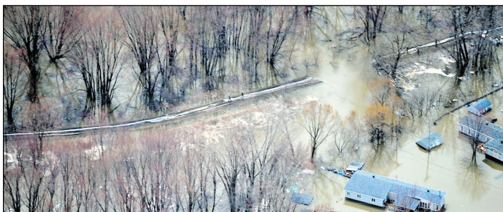
Figure 1.3 Digue cédant à l'eau à Sainte-Marthe-sur-le-Lac engendrant une inondation
