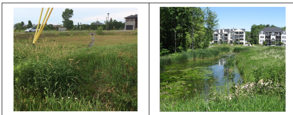
Figure 1.4 Exemple de bassin de rétention sec (gauche : collection personnelle) et humide (droite : Tiré de Ville de Saint-Jérôme (2009))
