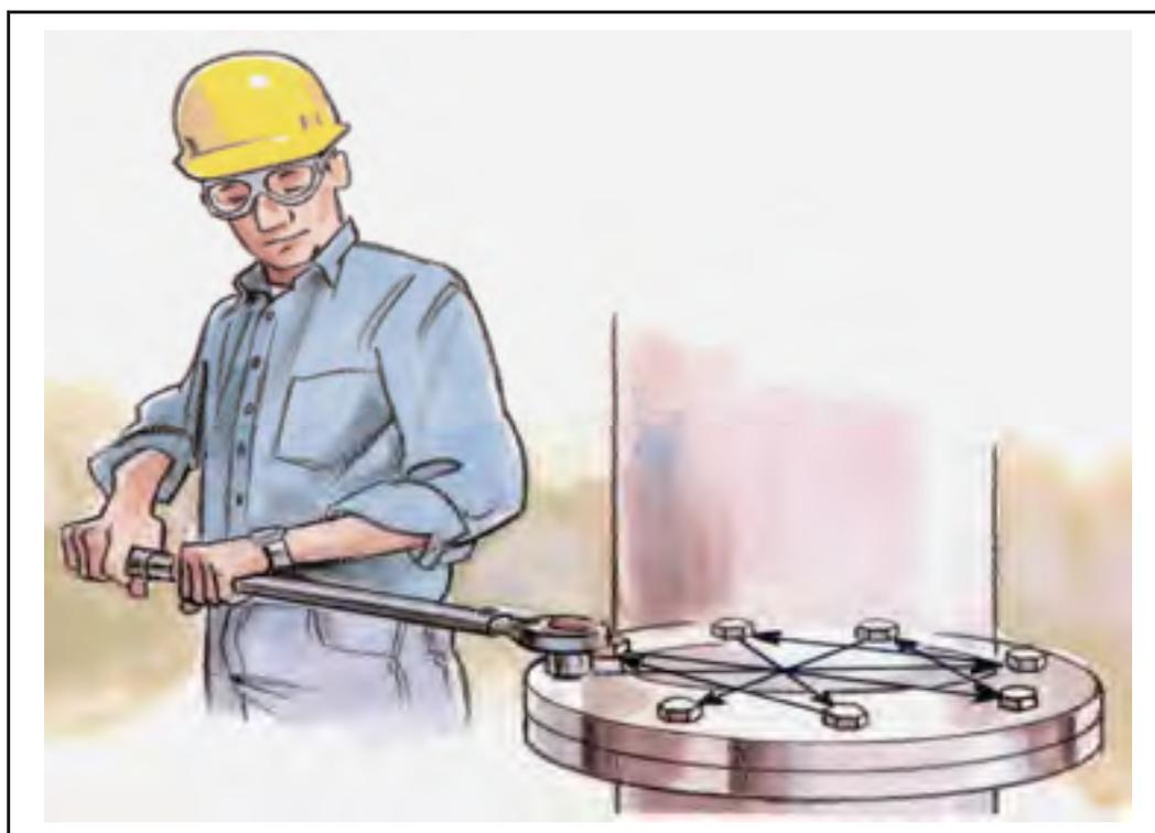
**Figure 0.2** Montage des brides à face plate.
