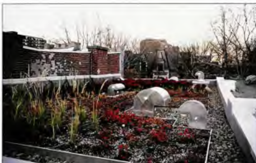
Figure 3.6 Toit vert du CEU de Montréal – période automnale.
