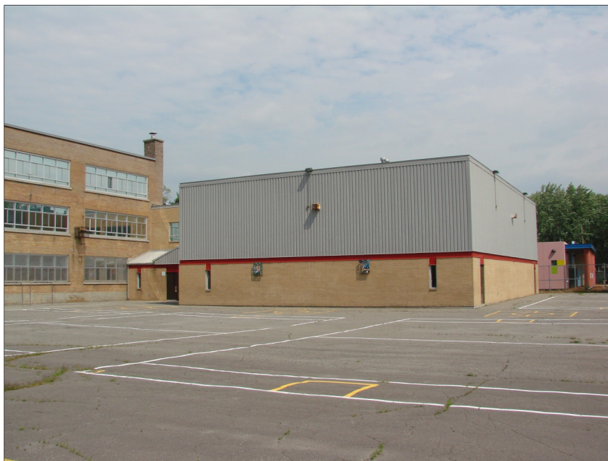
Figure 2.16 Irrégularité géométrique verticale de la même école
