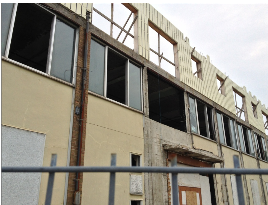
Figure 2.13 Ouvertures nombreuses et absence de remplissage de la même école sur le coté longitudinal
