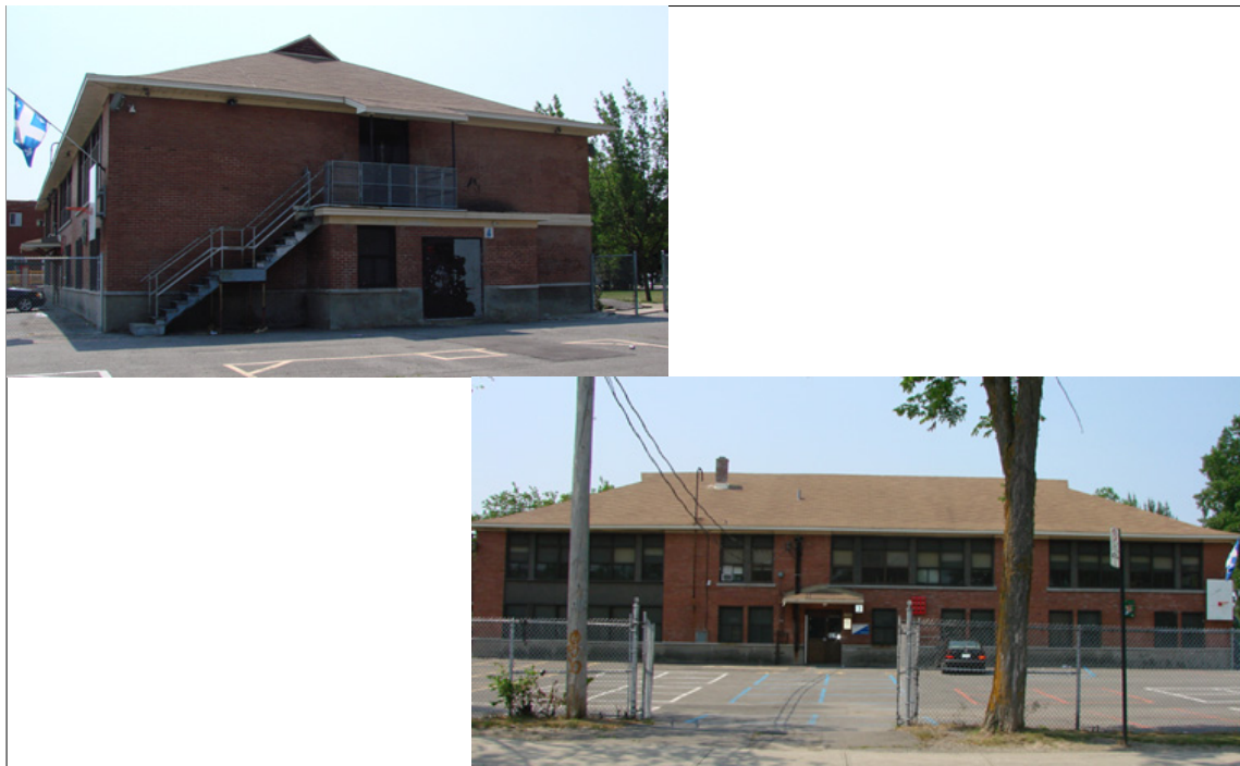
Figure 2.17 École primaire en bois avec un côté transversal plus rigide que celui longitudinal pouvant causer la torsion
