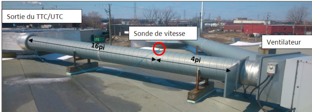
Figure 2.10 Illustration du positionnement axial de la sonde de mesure de la vitesse de l'air dans la conduite
