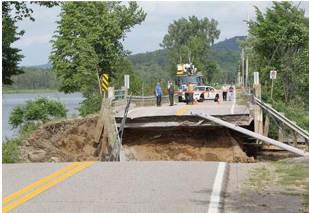
Figure 0.2 Dommages causés par le séisme de Val-des-Bois au Québec sur un pont près d'Ottawa Tirée de Gouvernement du Canada (2010)
