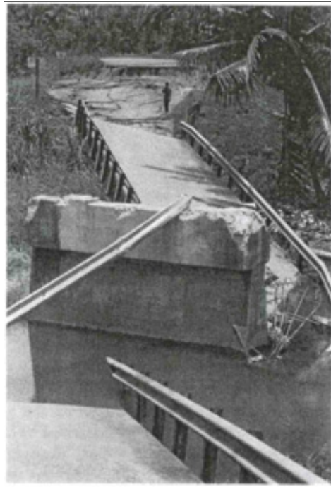
Figure 1.10 Perte d'appui et rupture d'une travée du pont Rio Bananito construit sur des sédiments de faibles résistances au cisaillement, (Costa Rica 1990) Tirée de Priestley (1996)
