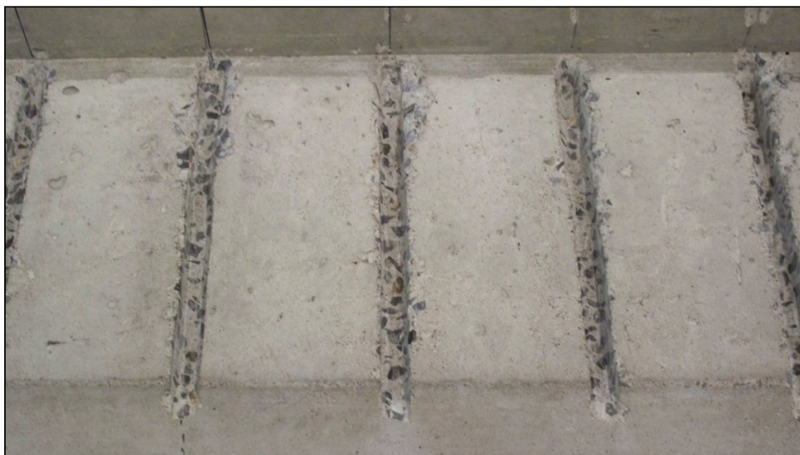
Figure-A II-3 Nettoyage des rainures.
