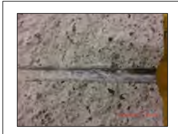
Figure 5.5 L'époxy reste collé sur le béton et la barre en CFRP s'est détachée en laissant une ruine
