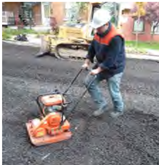
Figure 2.9 Compactage manuel de l'enrobé
