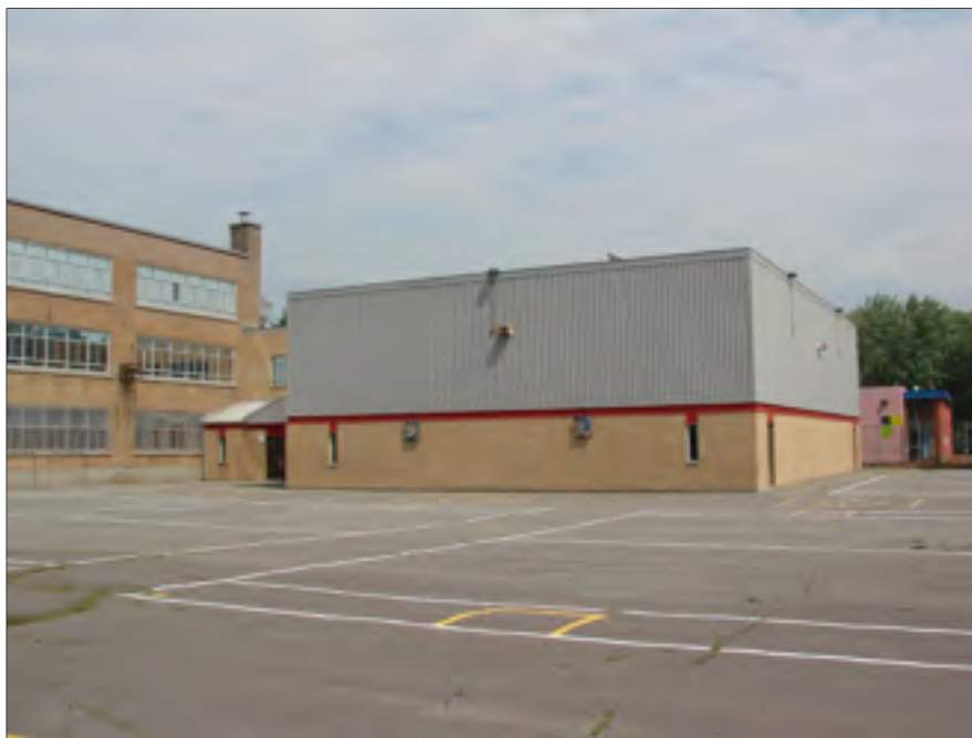
Figure 2.16 Irrégularité géométrique verticale de la même école
