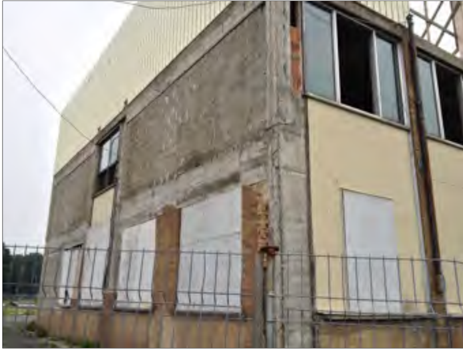
Figure 2.12 Remplissage en maçonnerie non armée sur le coté transversal
