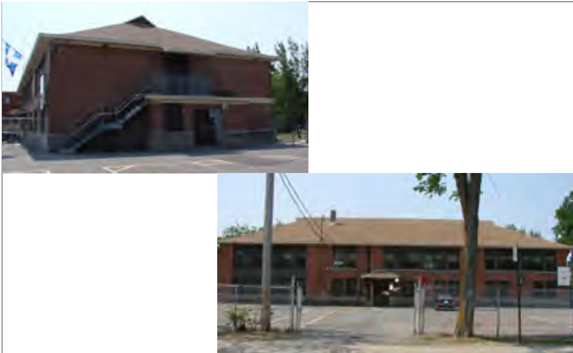
Figure 2.17 École primaire en bois avec un coté transversal plus rigide que celui longitudinal pouvant causer la torsion
