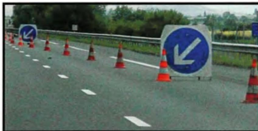
**Figure 2.49** *Exemple d'utilisation des cônes (2).*
