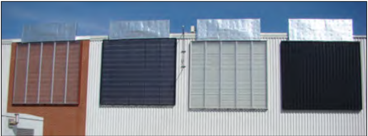
Figure 2.1 Photographie des collecteurs solaires perforés à air présents au CTGN
