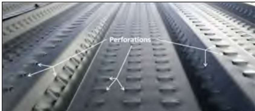
Figure 2.5 Localisation des perforations sur la plaque de l'UTC
