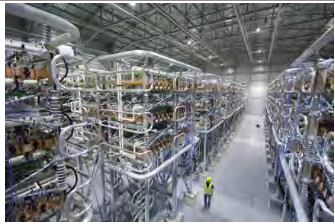
Figure 0.1 Convertisseur MMC industriel du fabricant Siemens © www.siemens.com/press
