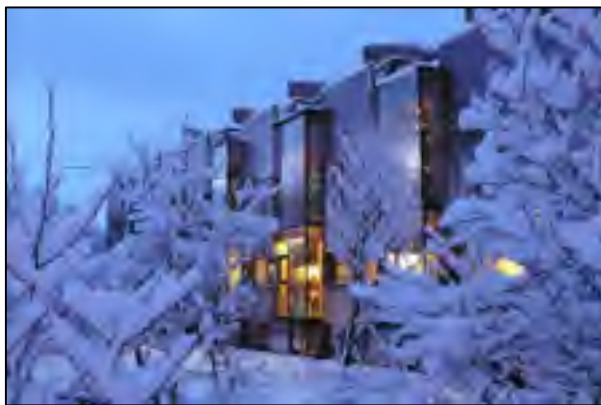
Figure 1-9: Vue sur les résidences I-box 120
