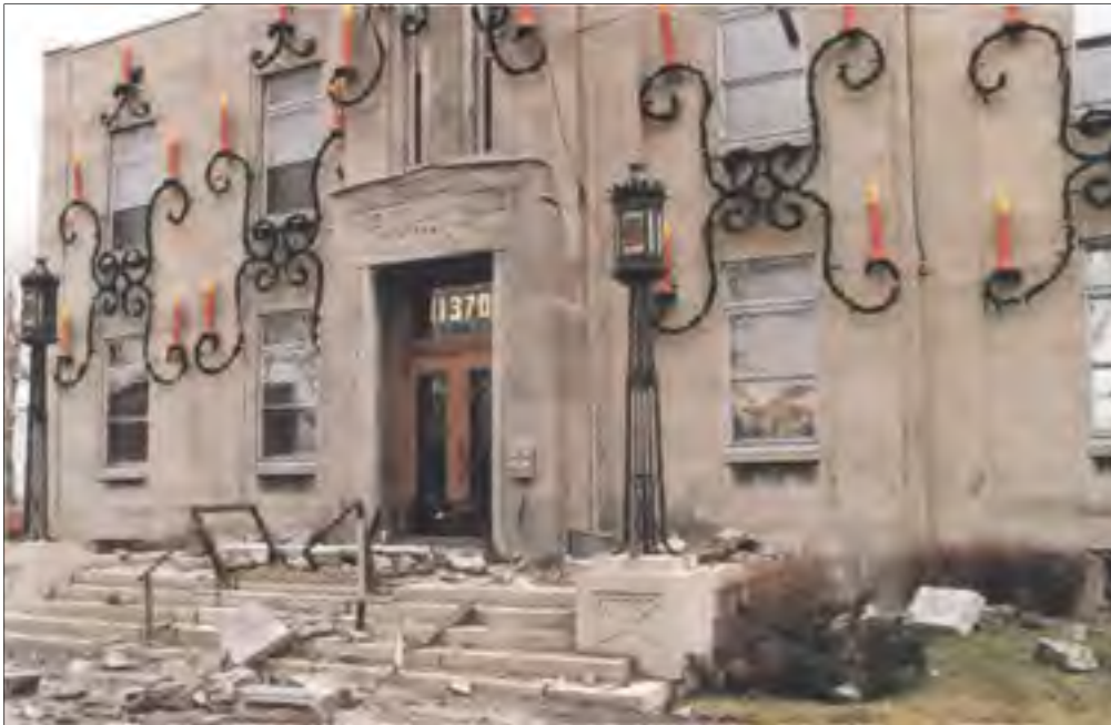
Figure 1.2 Dommage causé par le séisme de Saguenay sur l'Hôtel de ville de Montréal-Est Tirée de Gouvernement du Canada (2011)
