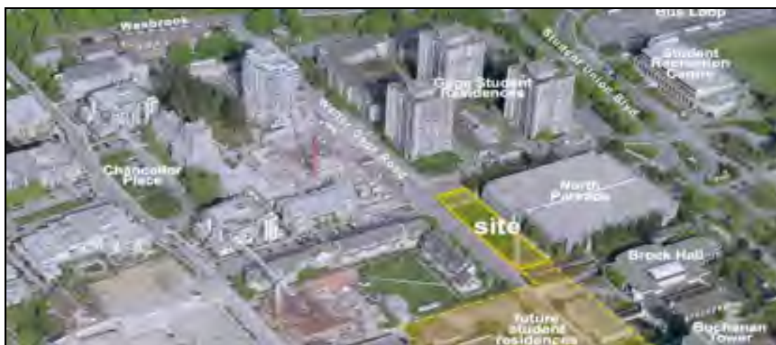
Figure 4.19 Vue aérienne du site du projet Brock-Commons. Tiré de TOPICs (2016)
