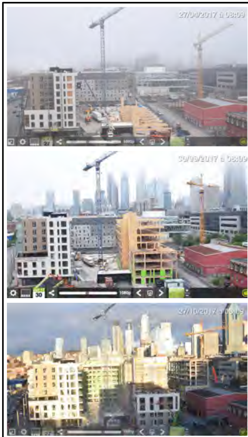
Figure 4.16 Évolution du chantier Arbora 2 Avril 2017 à Octobre 2017. (source : Devisubox)
