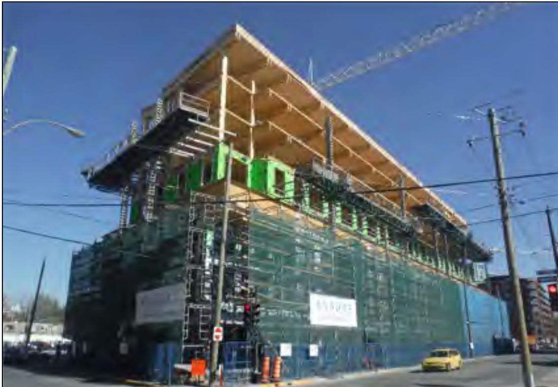
Figure 4.9 Photo du chantier Arpora 1 – Phase 1
