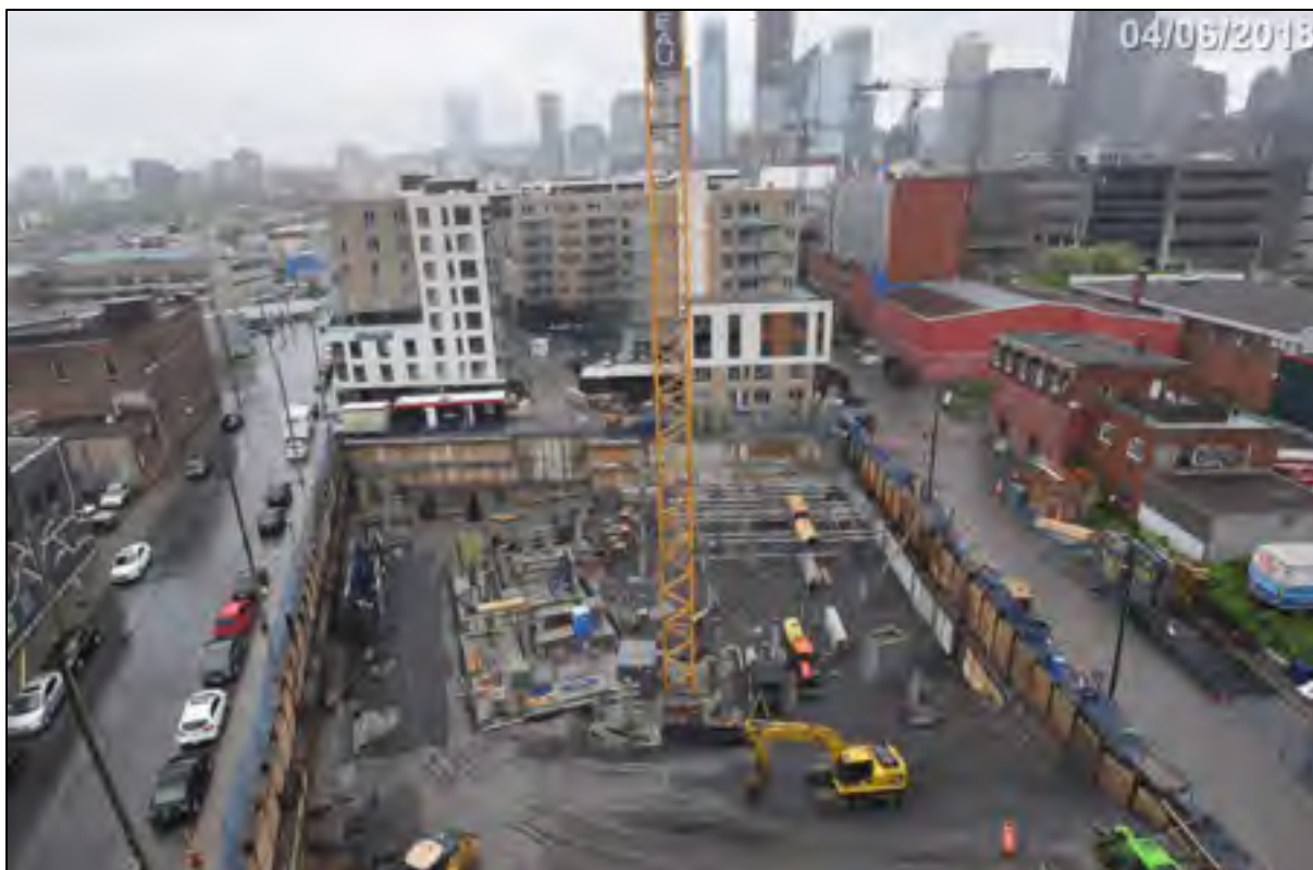
Figure 4.17 Arbora 3 – Début du chantier de la phase 3 Juin 2018 (source : Devisubox)
