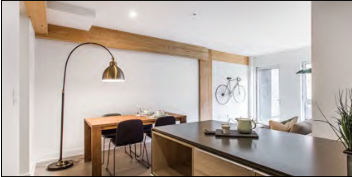
Figure 4.18 Arbora 1 – Intérieur d'un logement avec poutre et colonne apparentes (site ARBORA)
