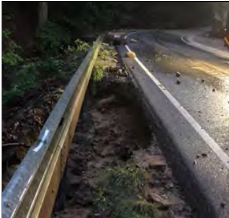
Figure 2.27 Érosion des accotements Tirée de Regenfällen (2018)
