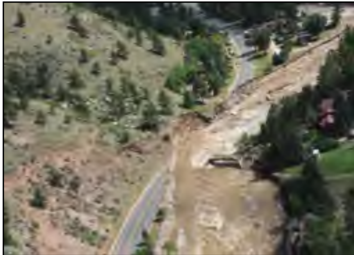
Figure 2.17 Dégâts causés par le blocage des ponceaux Tirée de Briaud & Maddah (2016)
