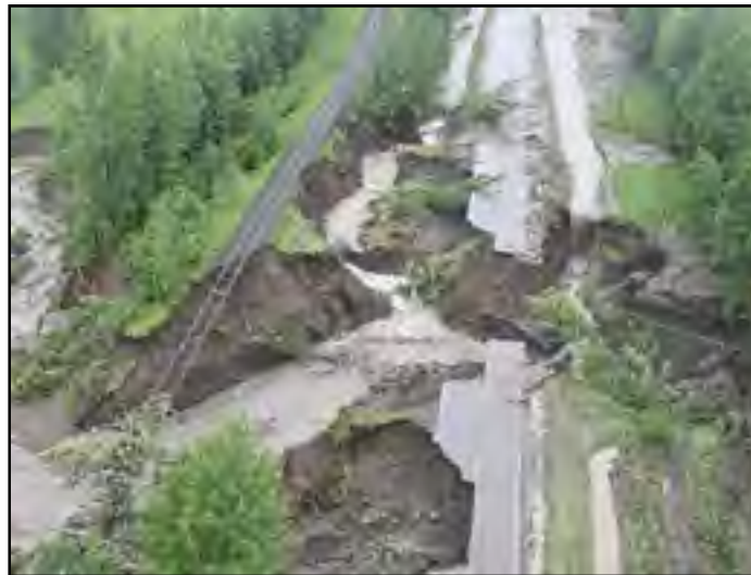
Figure 2.21 Érosion de route et chemin de fer Tirée de Davies (2016)
