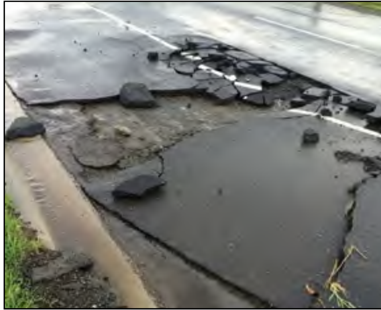
Figure 2.23 Soulèvement de couche de surface Tirée de Davies (2016)
