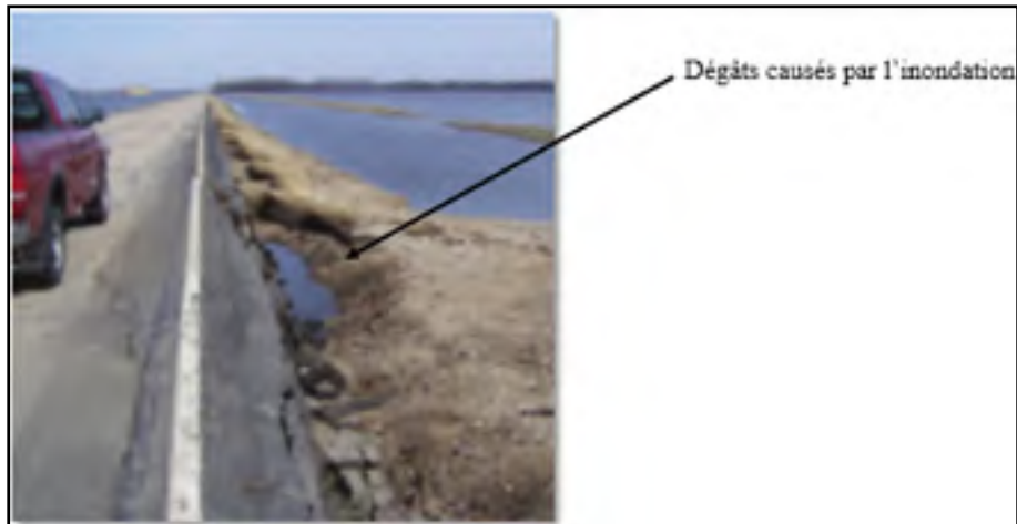
Figure 2.11 Dégâts suite à la submersion Adaptée de Briaud & Maddah (2016)
