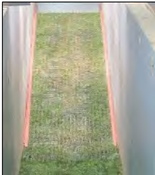
Figure 2.31 Gazon armé avec la couverture de contrôle d'érosion Tirée de Marr et al. (2017)
