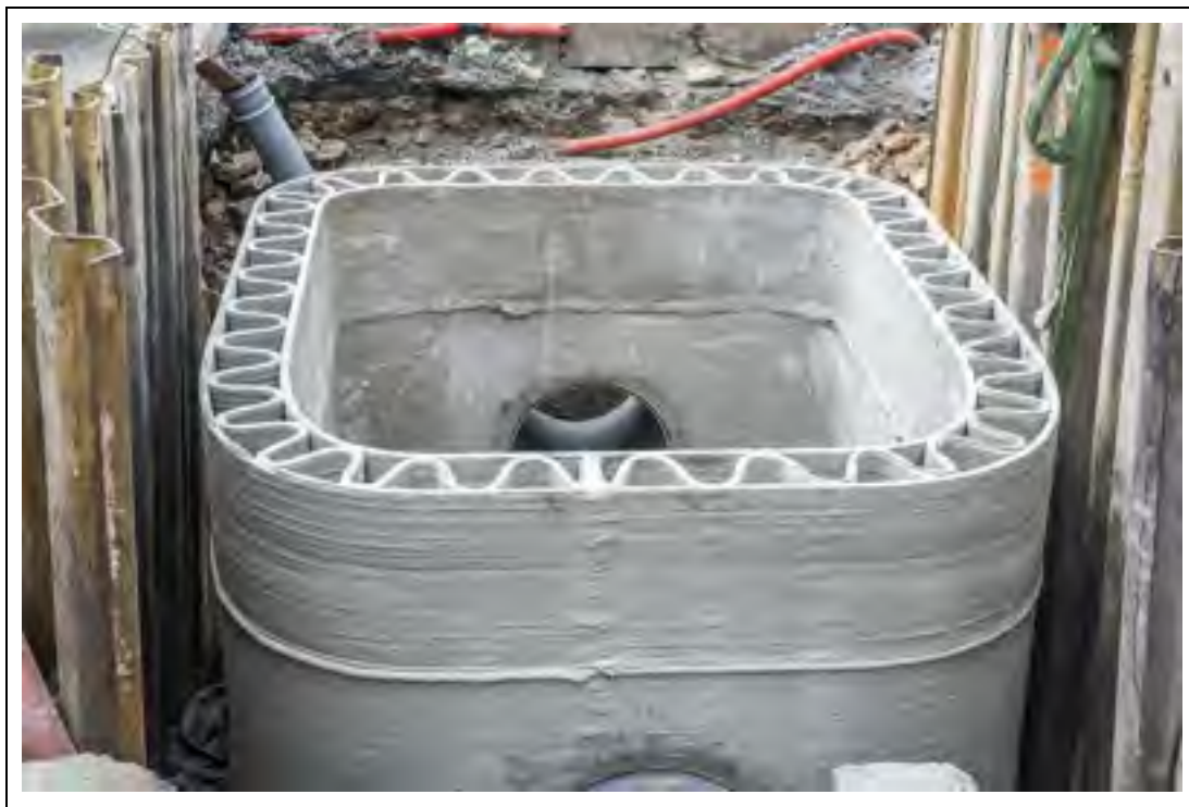
Figure 1.24 Collecteur d'eau de pluie imprimé en 3D Réalisation de l'entreprise (XtreeE, 2017c) http://www.xtreee.eu/projects-stormwater-collector/ Consulté en mars 2019
