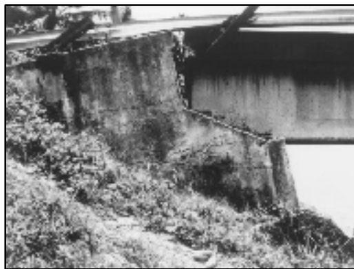
Figure 1.10 Rotation d'une culée Tirée de Mark et al. (2014)
