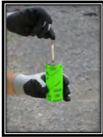
Figure 1.2 Insertion d'un détonateur dans une amorce
