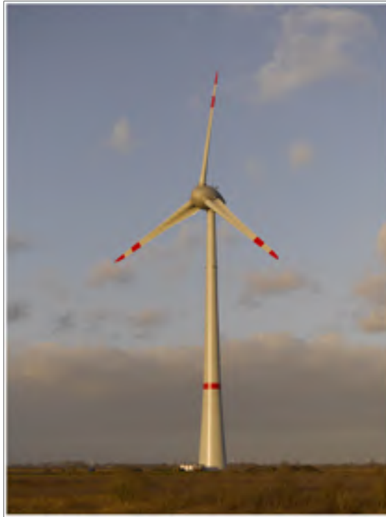
Figure 1.2 Éolienne Enercon E126, puissance nominale : 7MW, [4].
