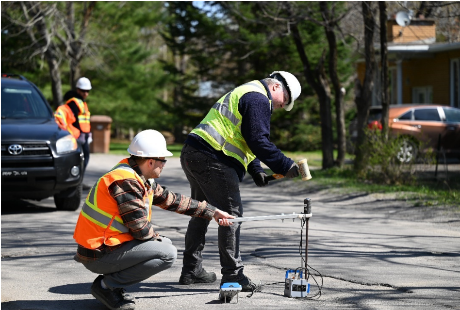
Figure 1.15 Réalisation d'un essai de DCP en chantier
