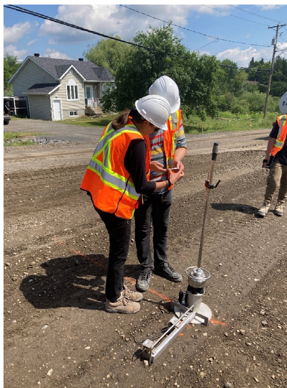
Figure 1.14 Réalisation d'un essai de LWD en chantier
