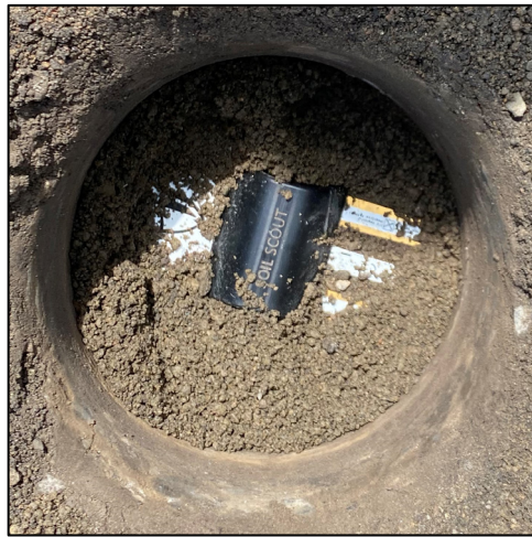
Figure 5.4 Installation du capteur dans le MR-5 stabilisé après compactage de la fondation stabilisée
