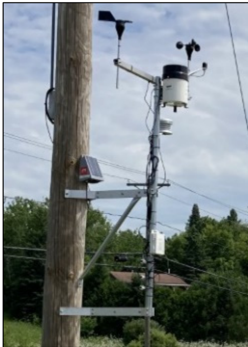
Figure 5.3 Fixation de la station météorologique à un poteau électrique à proximité du chantier
