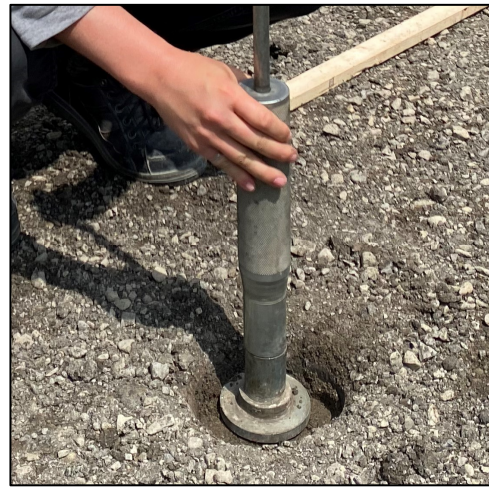
Figure 5.5 Compactage au marteau Marshall du MR-5 stabilisé recouvrant le capteur et avant compactage final de la fondation stabilisée
