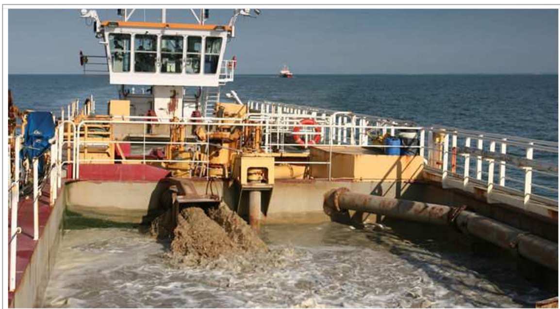
Figure 1.7 Refoulement des sédiments par drague hydraulique Tirée de GÉODE (2014)
