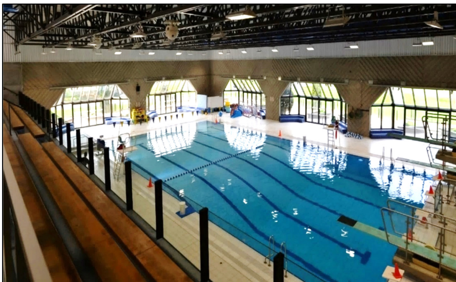
Figure 2.1 Photo de l'enceinte de la piscine étudiée
