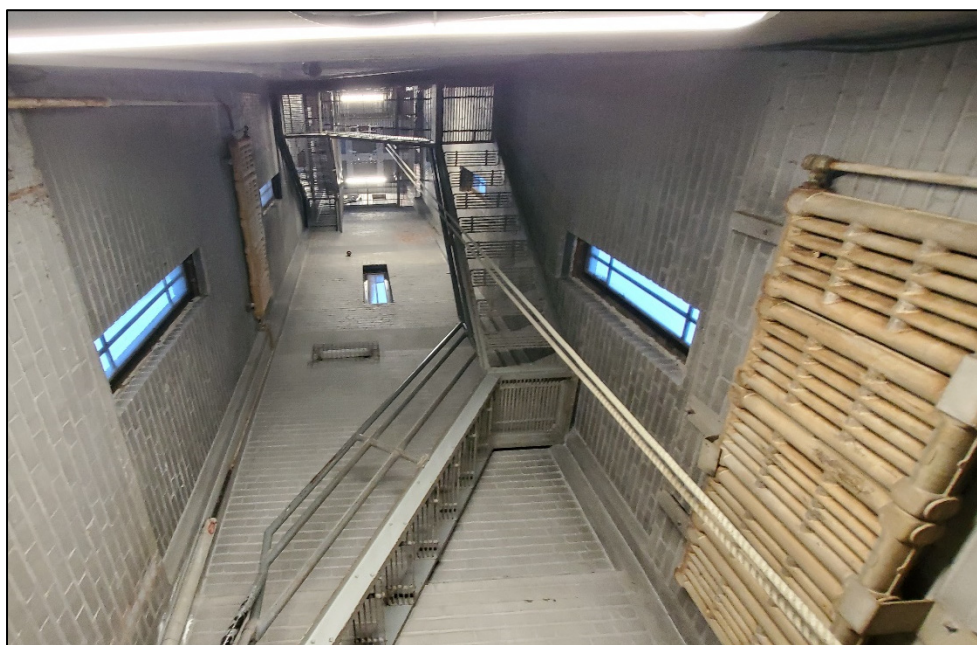
Figure 2.16 Radiateur en fonte dans une tour à boyaux
