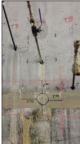
Figure A II-12 Emplacement du carottage sous le point T4
