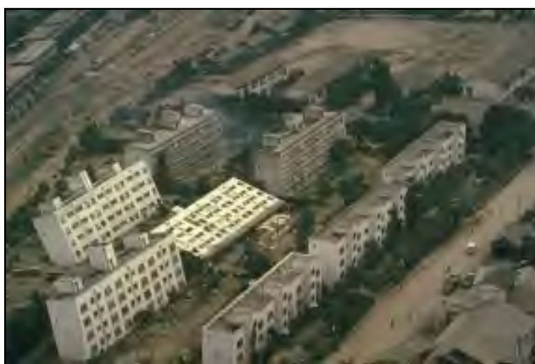
Figure 1.6 Renversement d'immeubles suite à la liquéfaction du sol lors du séisme de Niigata en 1964.
