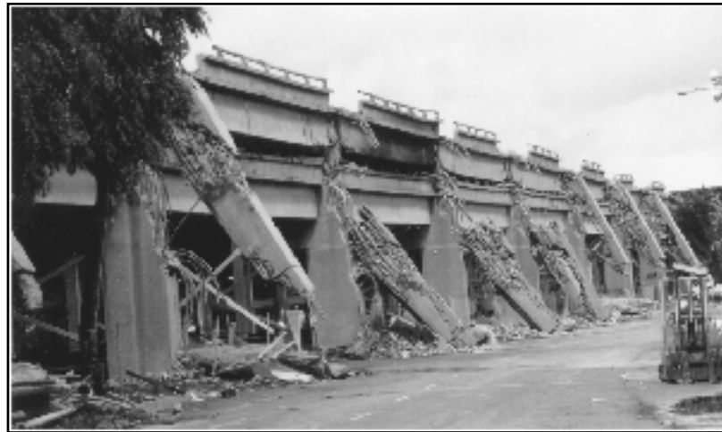
Figure 1.24 Effondrement du Cypress Street Viaduct lors du séisme de Loma Prieta. (Tiré de Chen et Duan, 2003)
