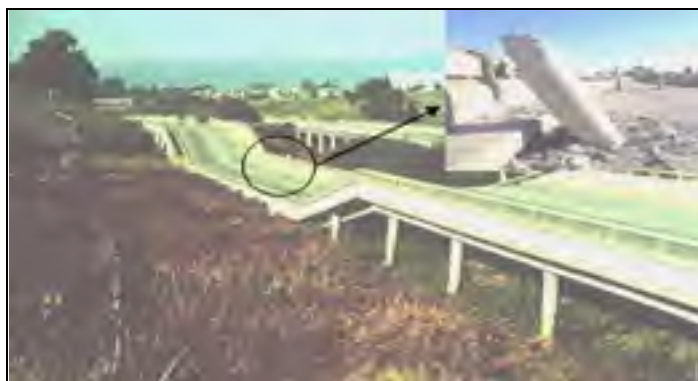
Figure 2.14 Effondrement du pont route 1, Struve Slough, Watsonville. Tirée de U.S.G.S (1989)
