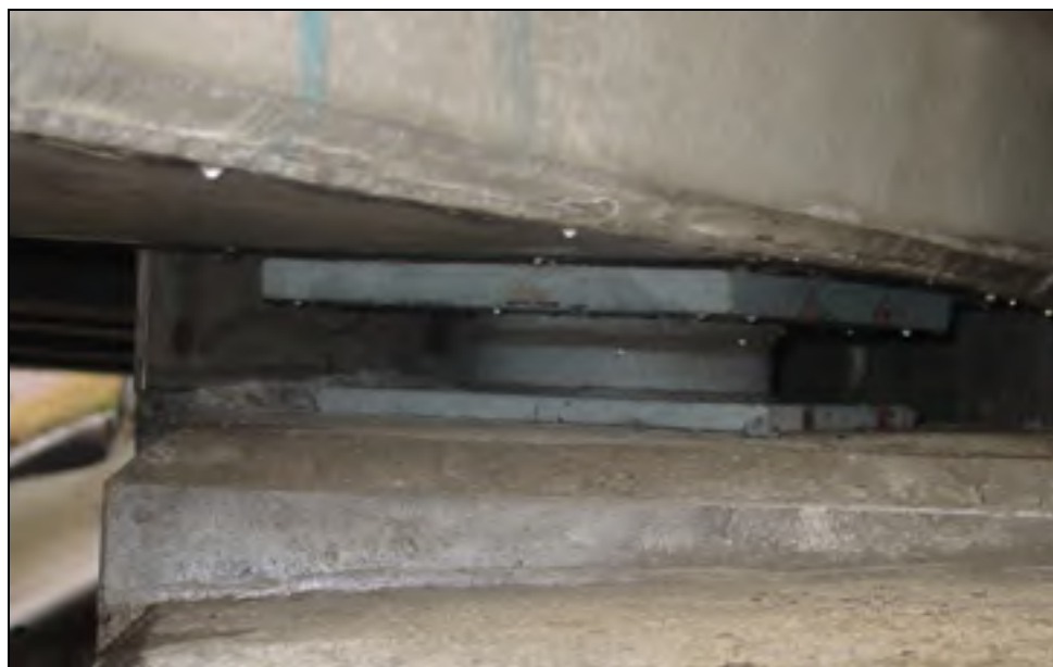
Figure 2.19 Appareils d'appuis en élastomère.
