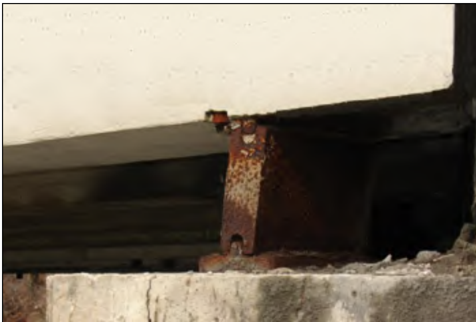
Figure 2.18 Appareils d'appuis à pendules.
