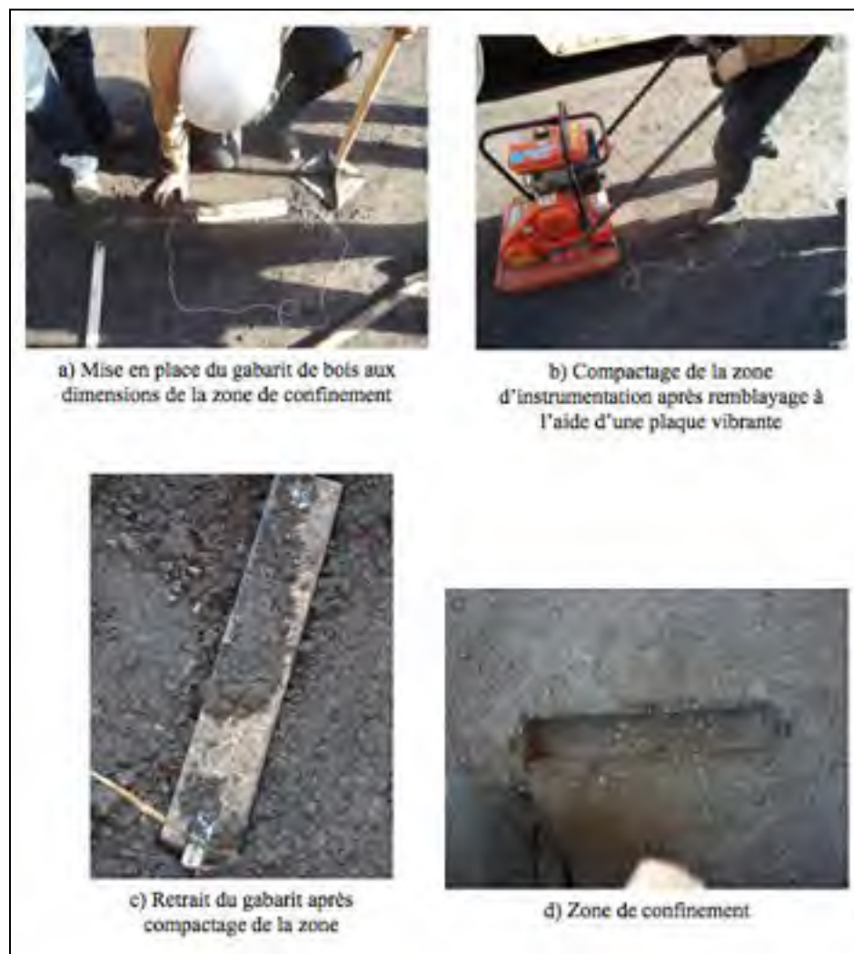
Figure 3.7 Réalisation de la zone de confinement dans la couche fraîchement mise en place
