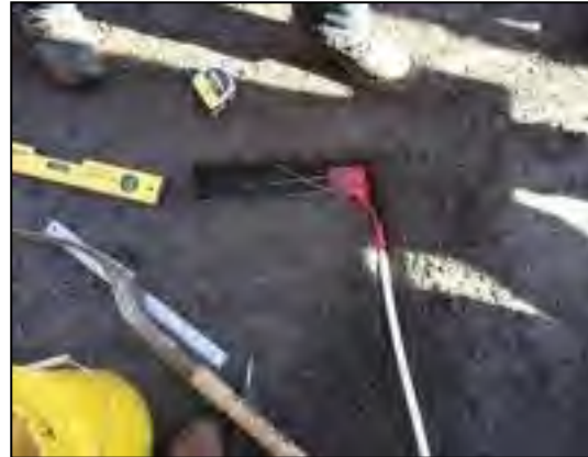
Figure 3.9 Mise en place de la sonde
