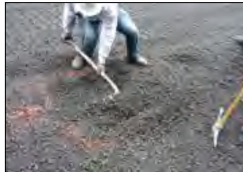
Figure 3.4 Délimitation de la zone d'instrumentation dans la couche fraîchement compactée
