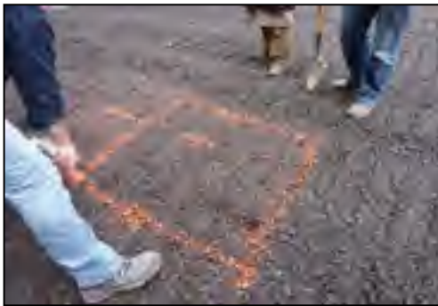
Figure 3.5 Excavation d'une surface d'environ 1m 2 jusqu'à la profondeur prédéfinie pour le positionnement de la sonde d'humidité
