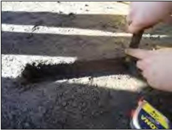
Figure 3.8 Vérification de la profondeur de la zone de confinement
