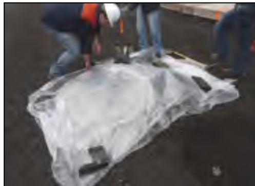
Figure 3.6 Protection du matériau excavé à l'aide d'un polythène
