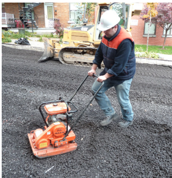
Figure 2.9 Compactage manuel de l'enrobé
