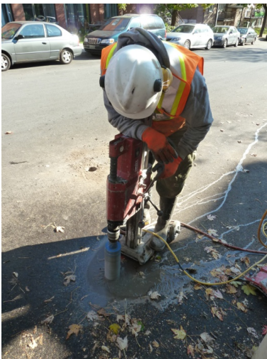
Figure 3.5 Carottage de l'éprouvette I-A le 28 octobre 2011
