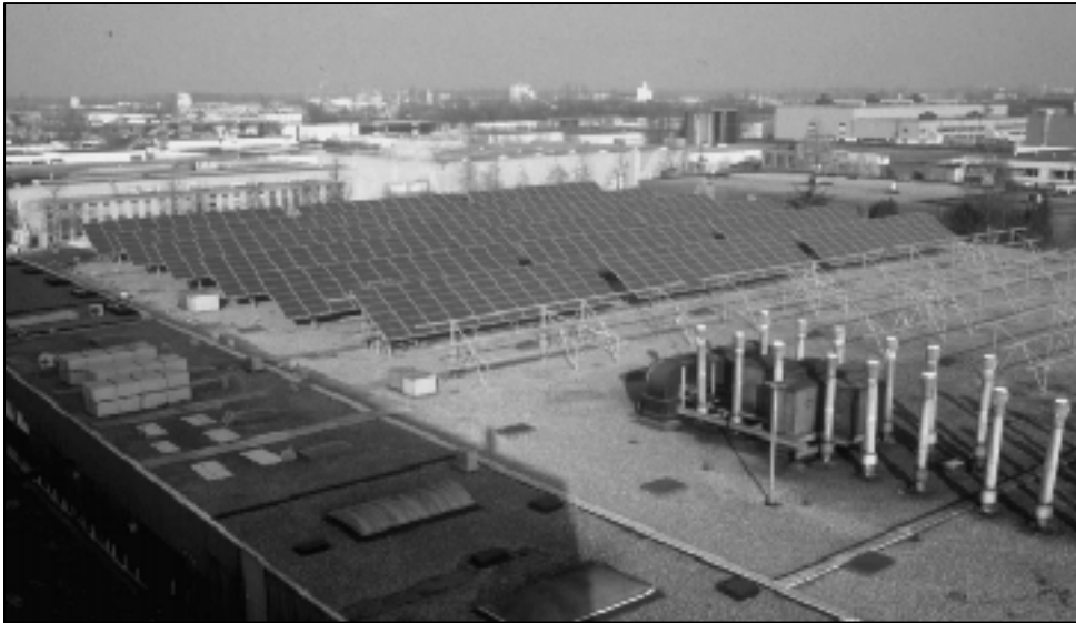
Figure 1.4 Système vidangeable industriel installé aux Pays-Bas, projet Van Melle (288 collecteurs à plan vitré, 24 rangées, 26 000 MJ/jour) Bokhoven, Van Dam et Kratz, 2001
