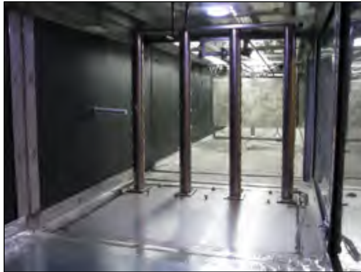
Figure 6.6 Rampe d'injection E6
