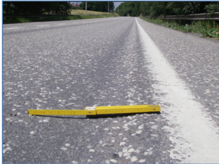
Figure 1.7 Dégradation due à l'orniérage Tirée de Eula (2011)
