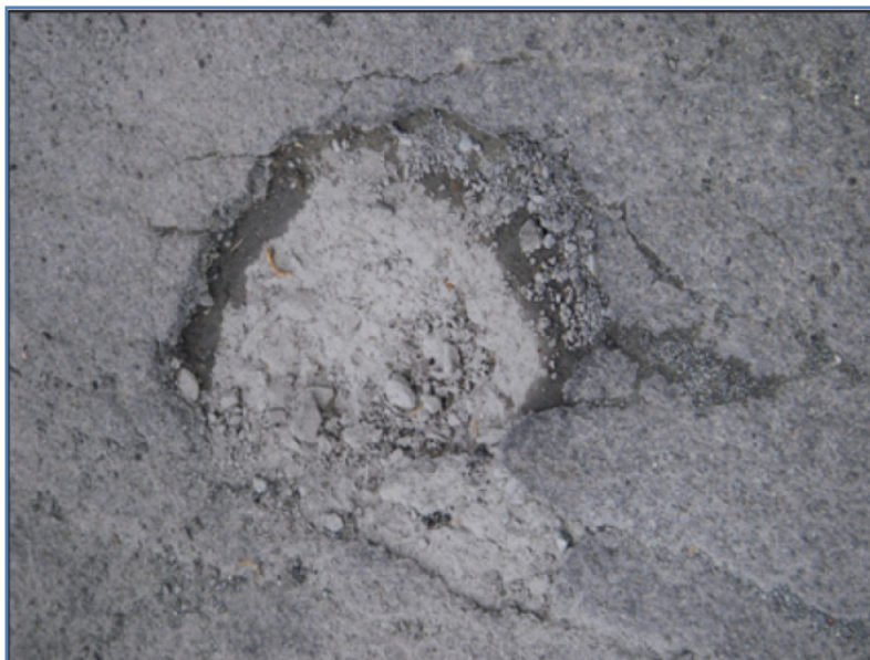
Figure 1.5 Photo illustrant la dégradation par désenrobage Tirée de Eula (2011)
