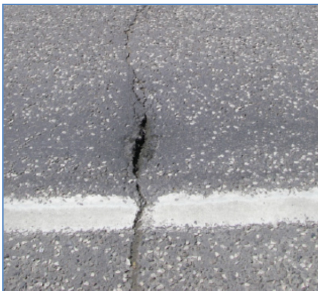
Figure 1.9 Dégradation par fissuration Tirée de Eula (2011)
