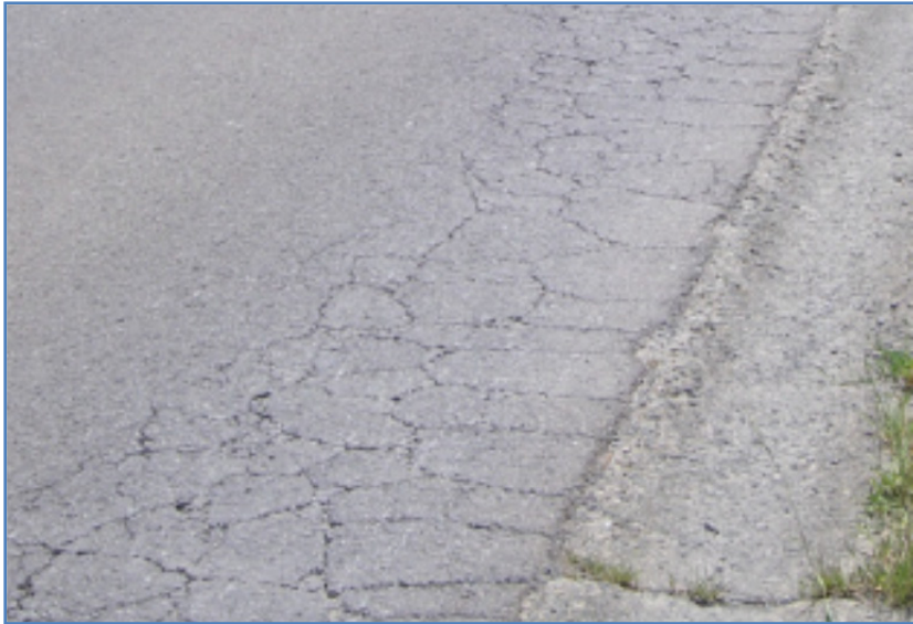
Figure 1.8 Dégradation causée par le vieillissement chimique Tirée de Eula (2011)
