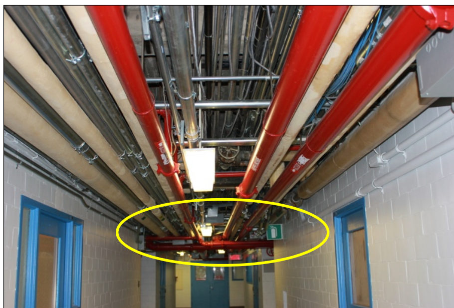
Figure 3.11 Cohabitation des systèmes d'ingénierie desservant un hôpital
