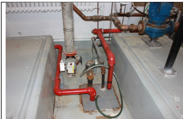
a) raccordement de l'alimentation en eau au réseau de ville
