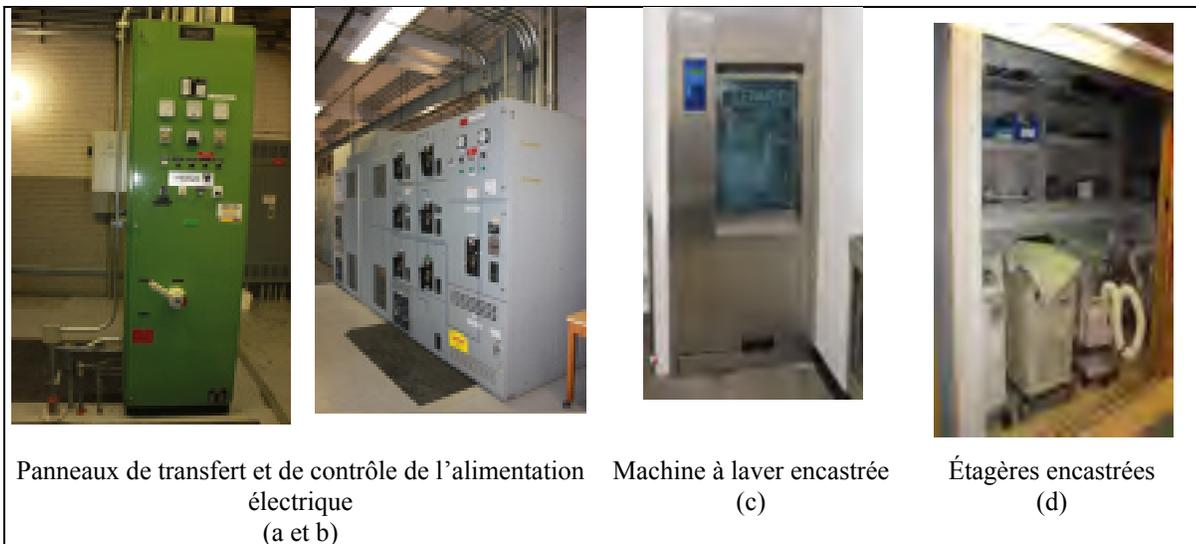
Figure 5.16 Exemples de CFO élancés et conditions de fixation
