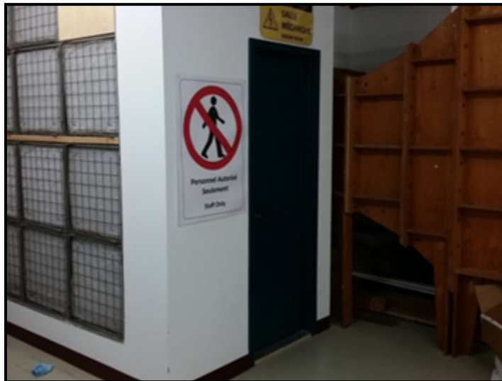
Figure-A-I-1 Extérieur de la salle mécanique
