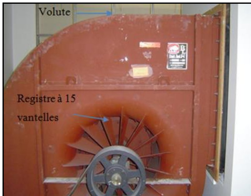
Figure-A-I-4 Ventilateur centrifuge à double turbine
