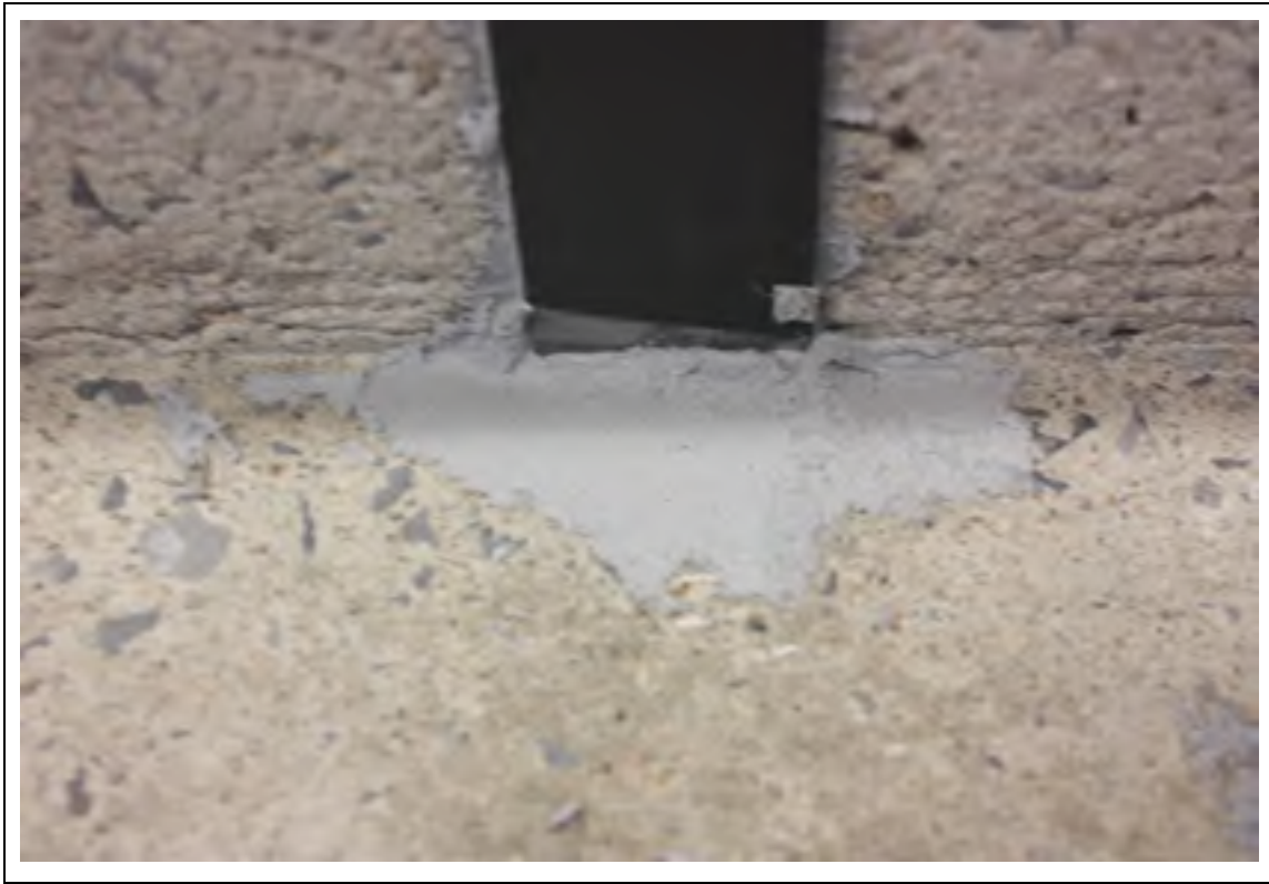
Figure 3.6 Préparation du spécimen S1-LS-PA, ancrage partiel
