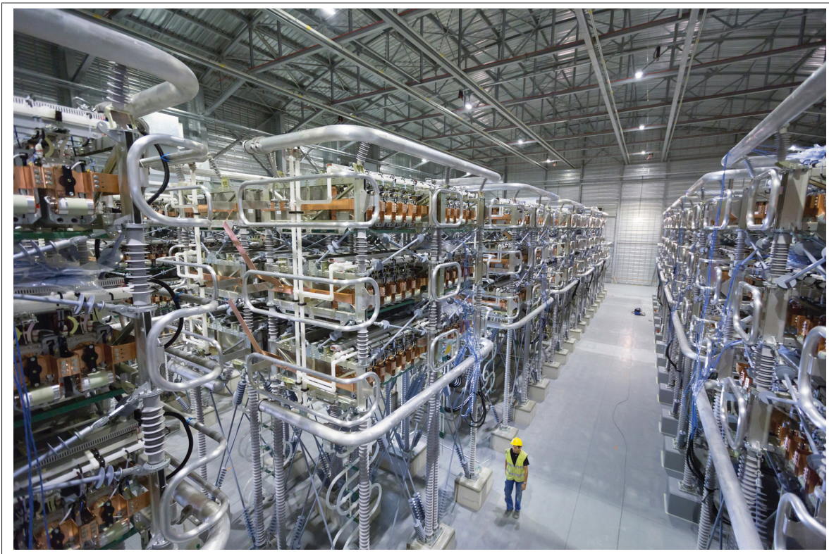
Figure 0.1 Convertisseur MMC industriel du fabricant Siemens © www.siemens.com/press
