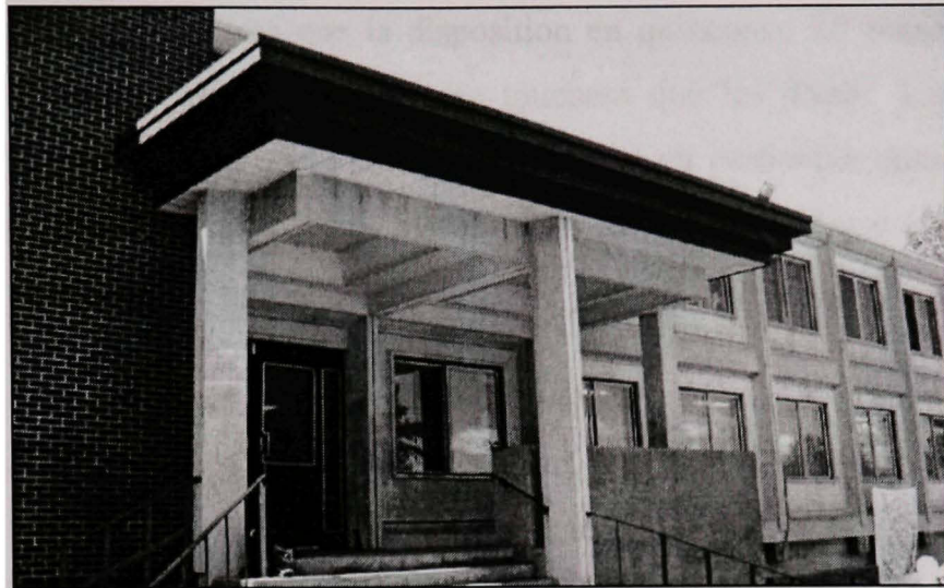
Figure 3.20 Auvent en béton préfabriqué d'une école « tilt-up ».
