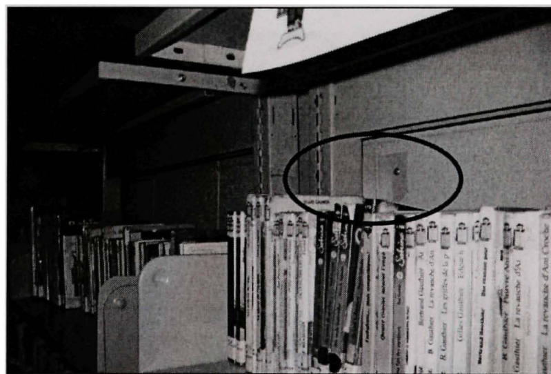
Figure 3.31 Fixation des rayonnages aux murs.
