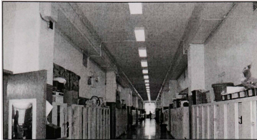
Figure 3.28 Luminaires vissés au plafond.
