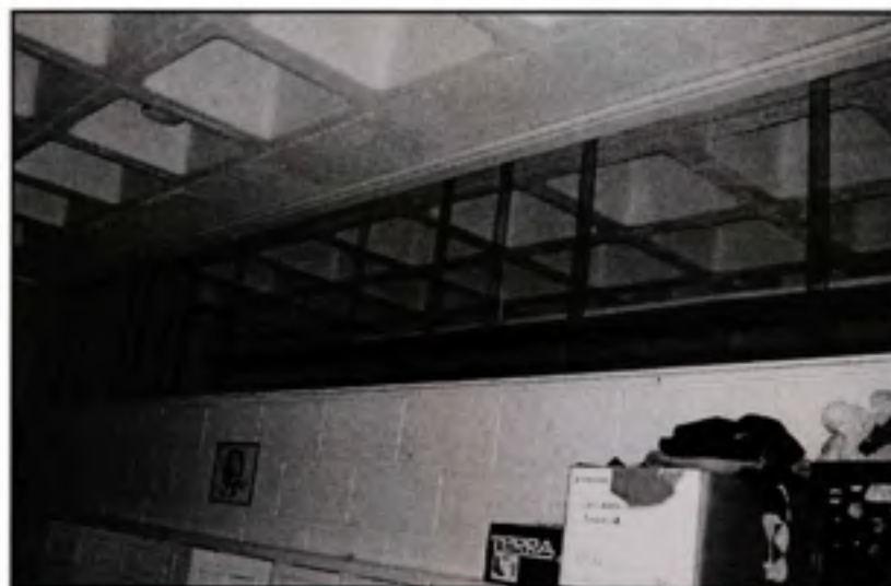
Figure 3.33 Vitres en verre traditionnel en partie supérieure des cloisons.
