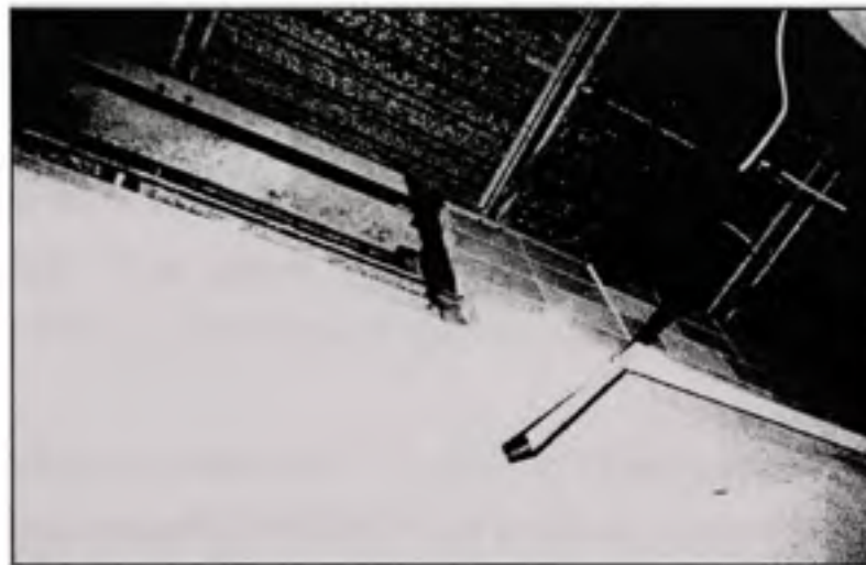
Figure 4.3 Rupture des blocs de béton dans la partie supérieure du mur de la nouvelle aile de l'école polyvalente Dominique Racine.
