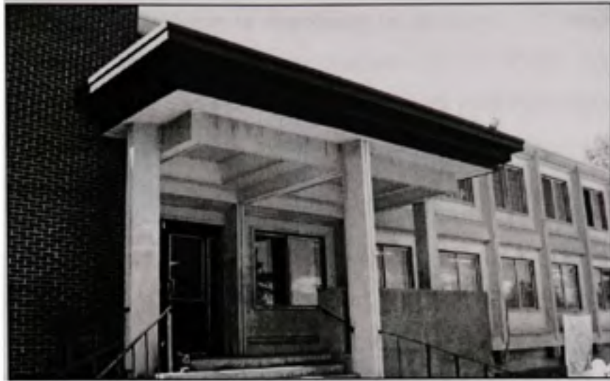
Figure 3.20 Auvent en béton préfabriqué d'une école « tilt-up ».
