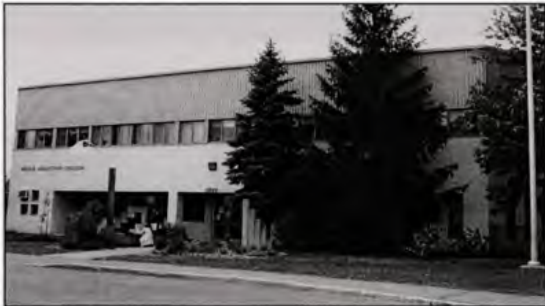
Figure 3.17 Façade avant de l'école 5-A.
