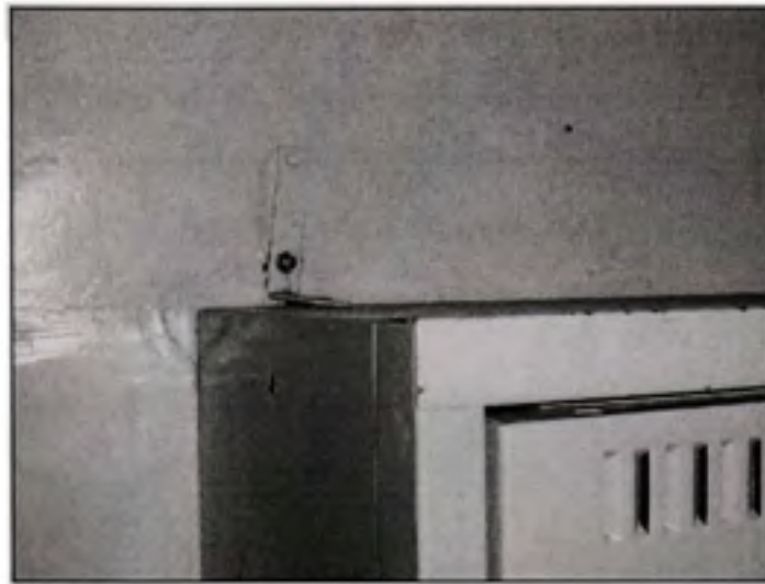
Figure 3.30 Fixation des casiers aux murs en partie supérieure.
