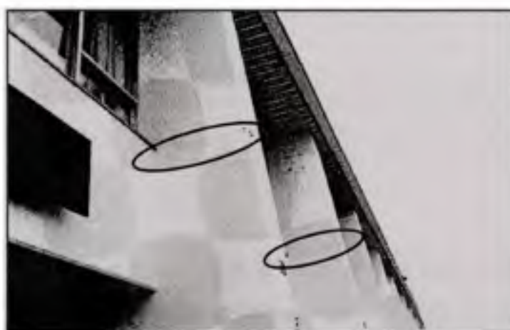
Figure 4.5 Fissures horizontales dans les colonnes extérieures de l'ancienne aile de l'école polyvalente de La Baie. (Tinawi, Mitchell et Law, 1989)
