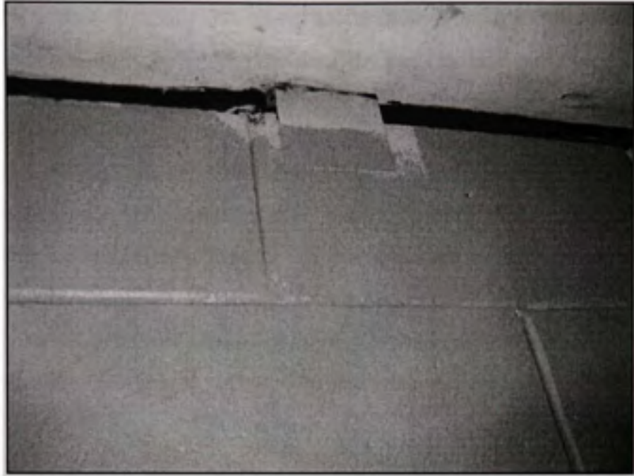
Figure 3.23 Ancrages des blocs de béton en partie supérieure.
