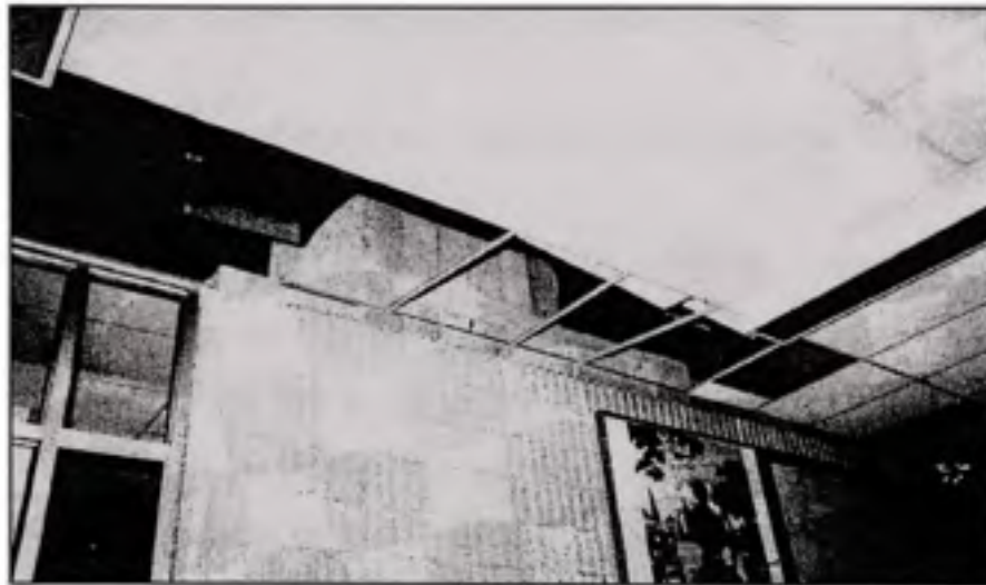
Figure 4.7 Blocs de béton endommagés dans un corridor de l'école polyvalente Dominique Racine à Chicoutimi. (Tinawi, Mitchell et Law, 1989)
