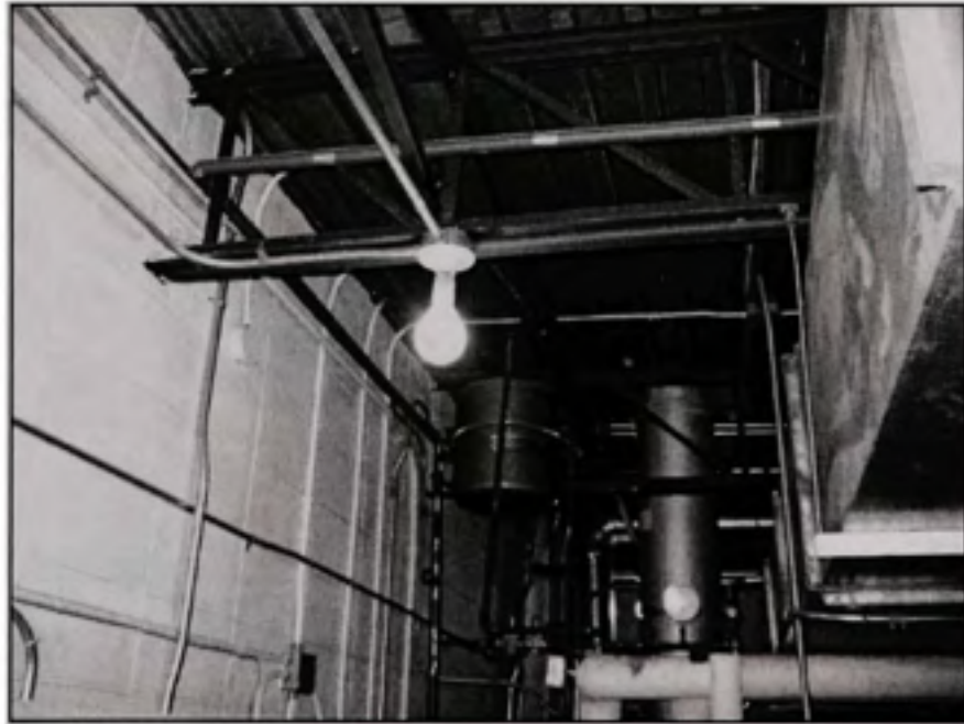
Figure 3.24 Poutrelles triangulées d'acier traversant les cloisons de blocs de béton.
