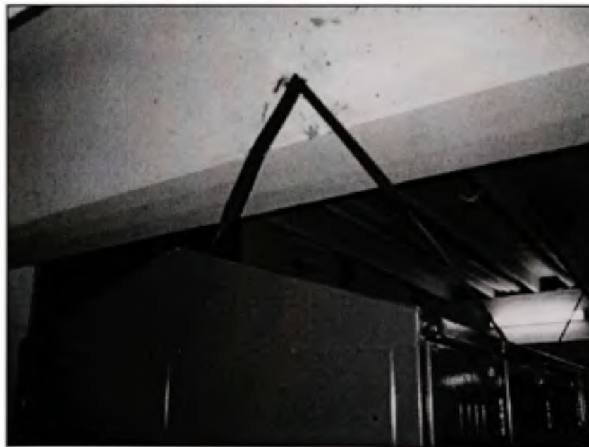
Figure 3.29 Fixation des casiers à des poutres.
