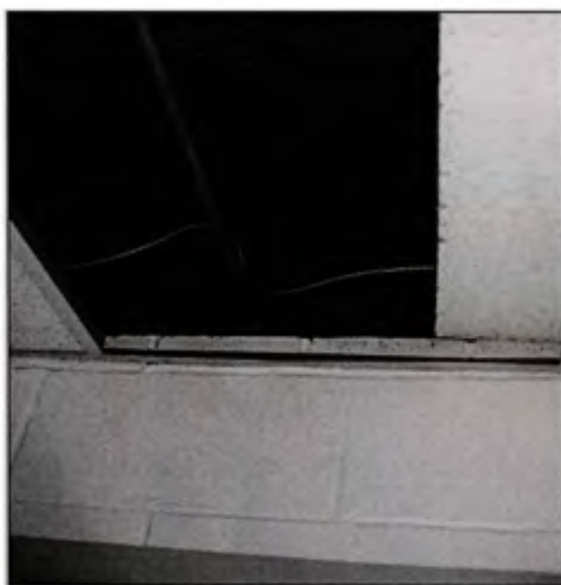
Figure 3.22 Cloison de blocs de béton s'arrêtant au-dessus du faux-plafond.
