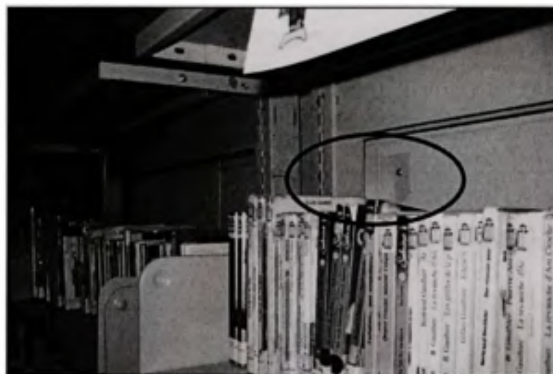
Figure 3.31 Fixation des rayonnages aux murs.
