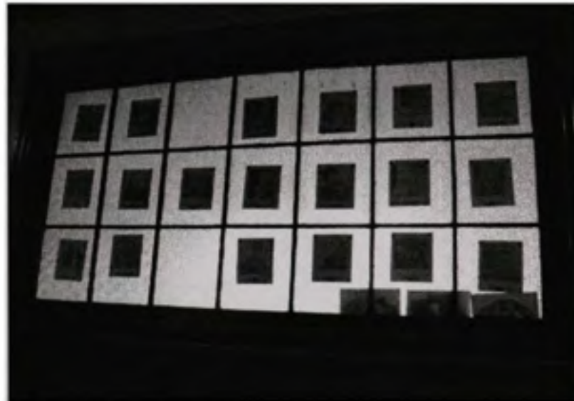
Figure 3.32 Petits carreaux de verre traditionnel en partie supérieure des cloisons.
