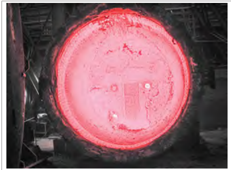
Figure 1.2 Briquetage réfractaire chaud d'une poche en attente sur le quai de préchauffage.
