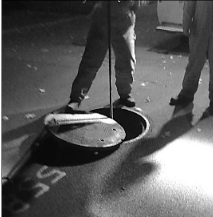
Figure 3.18 Fermeture de l'une des trois vannes pour isoler le secteur à l'étude
