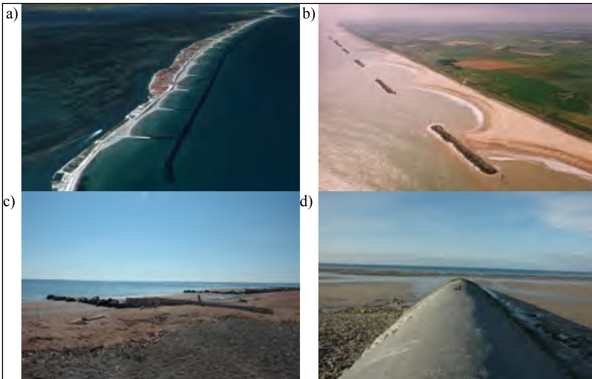
Figure 1.3 Mesures de lutte contre l'érosion côtière incluses dans la catégorie Structure de stabilisation a) Brise-lame détaché submergé – Deltares.nl; b) Brise-lame détaché émergé – www.gov.uk; c) Épis maritimes (bois) – Hope Town, Québec; d) Épi-buse (béton) – Luc-sur-Mer, France
