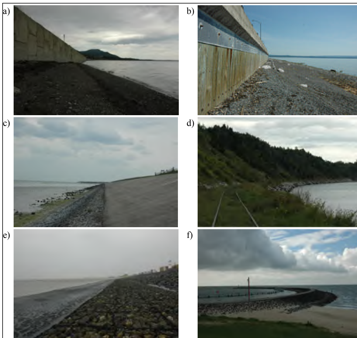
Figure 1.2 Mesures de lutte contre l'érosion côtière incluses dans la catégorie Structure de renforcement a) Mur vertical (béton) – Carleton-sur-Mer, Québec; b) Mur vertical (bois) – Maria, Québec; c) Revêtement (enrobé bitumineux) – Texel, Pays-Bas; d) Revêtement (enrochement) – Carleton-sur-Mer, Québec; e) Revêtement (grillage) – Brouwersdam, Pays-Bas; f) Brise-lame – Stavoren, Pays-Bas
